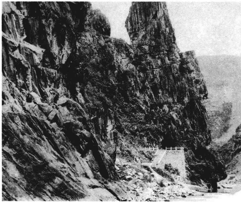
古石门隧道南口全貌 在石门南口西侧的山崖间，有一排栈孔，下距谷底八米，见方三八至四〇厘米，深八〇至一〇〇厘米，彼此间隔二至三米。《史记·高祖本纪》《索隐》引崔浩云：“险绝之处，傍凿山崖，而施版梁为
