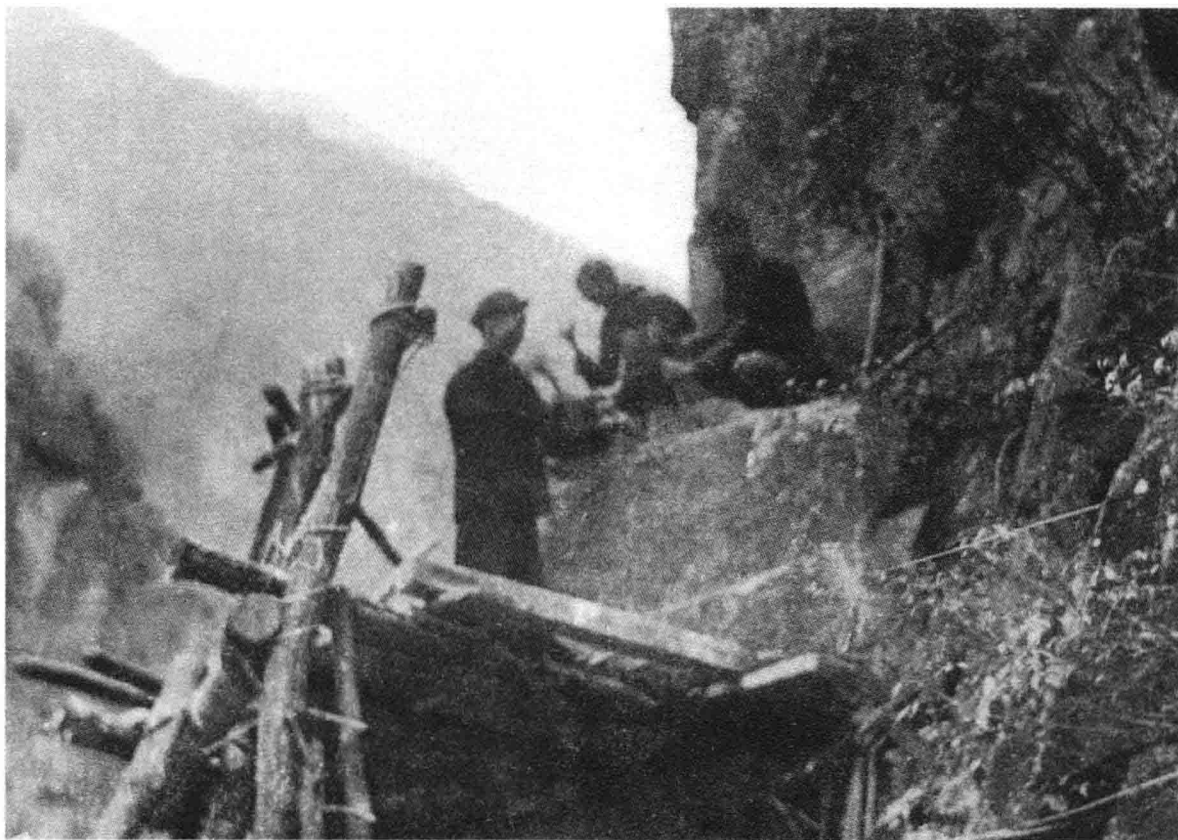
汉《郾君开通褒斜道摩崖》和南宋晏袤《释郾君开通褒斜道摩崖》被凿迁的情景。(图十五)
