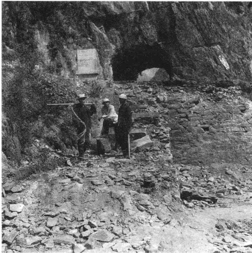
建坝初期的古石门隧道南口全貌在修建石门大坝中，古石门隧道中的著名汉魏摩崖《石门颂》、《石门铭》等，皆被凿迁，并从南口运出。为有利于搬运，拆毁了原有的高台。(图十四)
