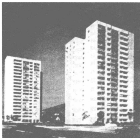
图4 采用砌体承重墙建于瑞士的高层房屋
