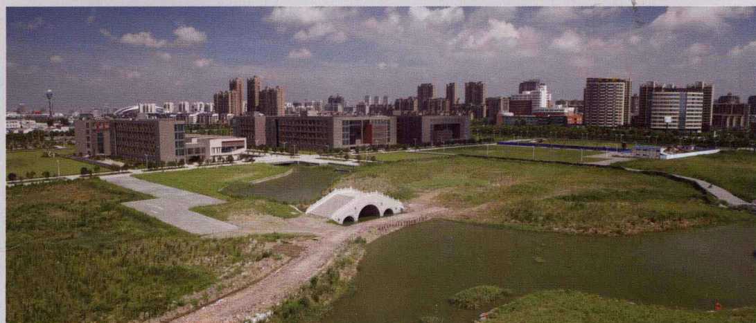
石桥河畔同 济浙江学院 教学楼
