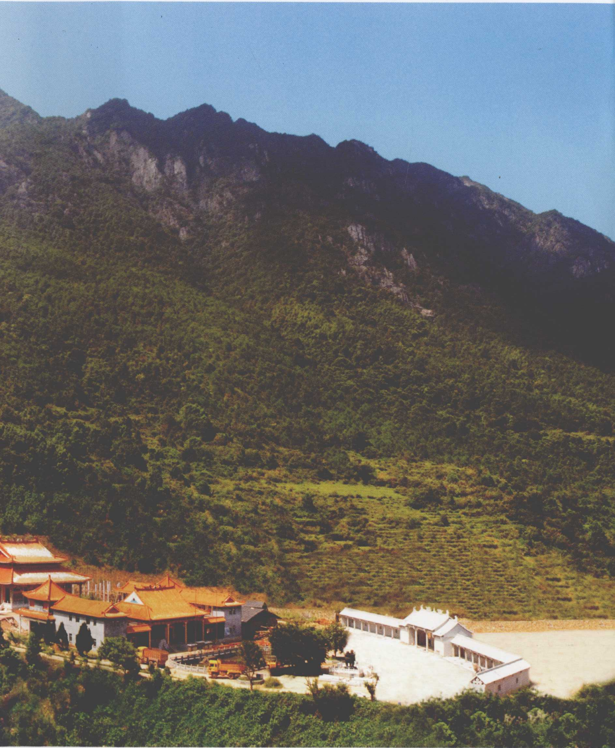
建设中的万福寺全景
