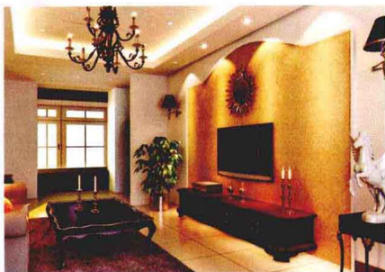
壁纸+石膏板，石膏板造型，面层喷涂乳胶漆，里层贴壁纸，造价约230元/平方米。
