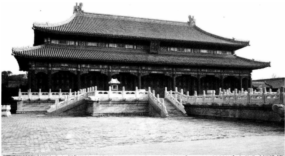
皇极殿虽不在中轴线上，却是级别很高的重檐庑殿顶建筑
