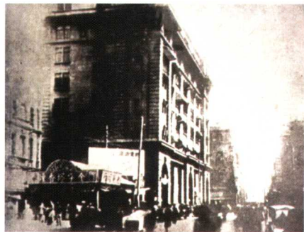
设在上海的汉冶萍公司总事务处大楼
