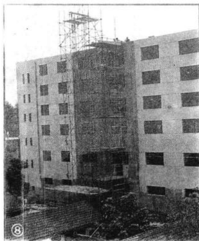
由我队进行桩基施工的 南阳军分区综合楼
