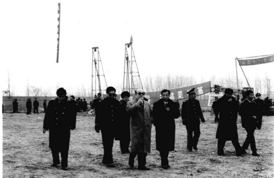
一九九五年底中共南阳市委副书记侯玉德参加我队 为市公安局通讯指挥大楼施工的桩基工程开工典礼
