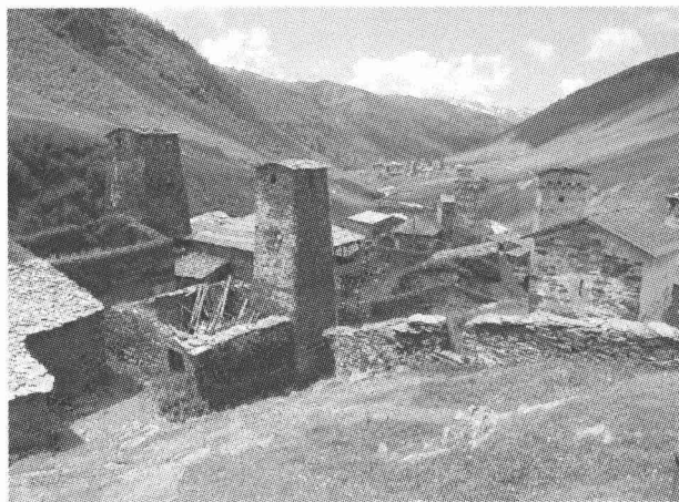
图3 上斯瓦涅季村落和塔屋 · 格鲁吉亚 · 乡土建筑遗产
