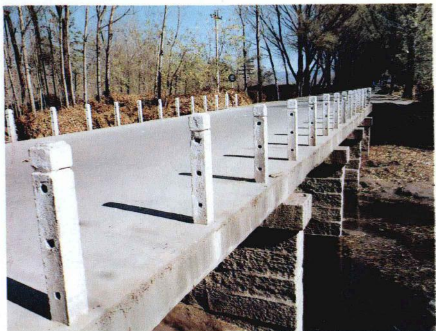
延庆第一座钢筋混凝土桥——新华营桥
