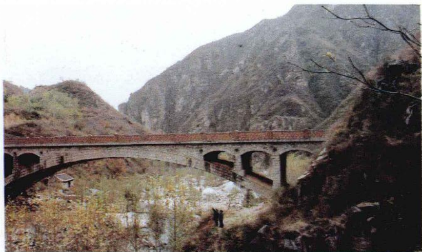
山区乡队公路上的旺泉沟大桥
