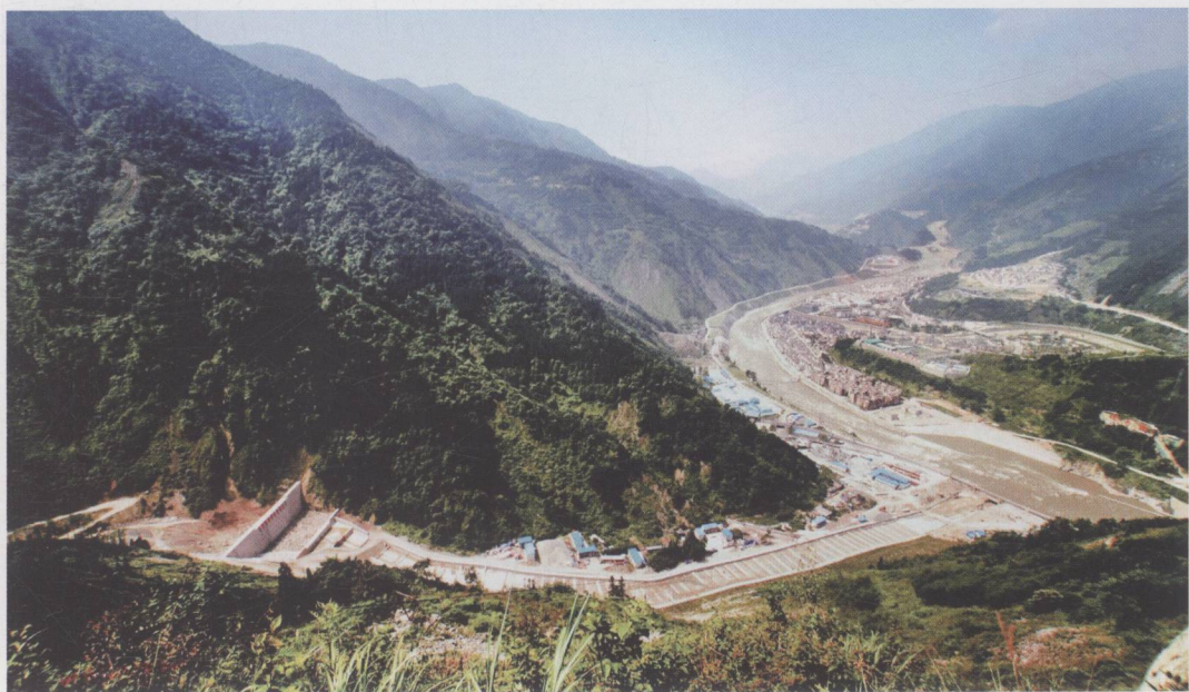
建立健全地质灾害防治体制机制，在基础调查、应急抢险、工程治理上取得重大进展，应对重大自然灾害的能力不断提高，地质灾害防治成效显著。图为泥石流灾害应急抢险排危工程。
