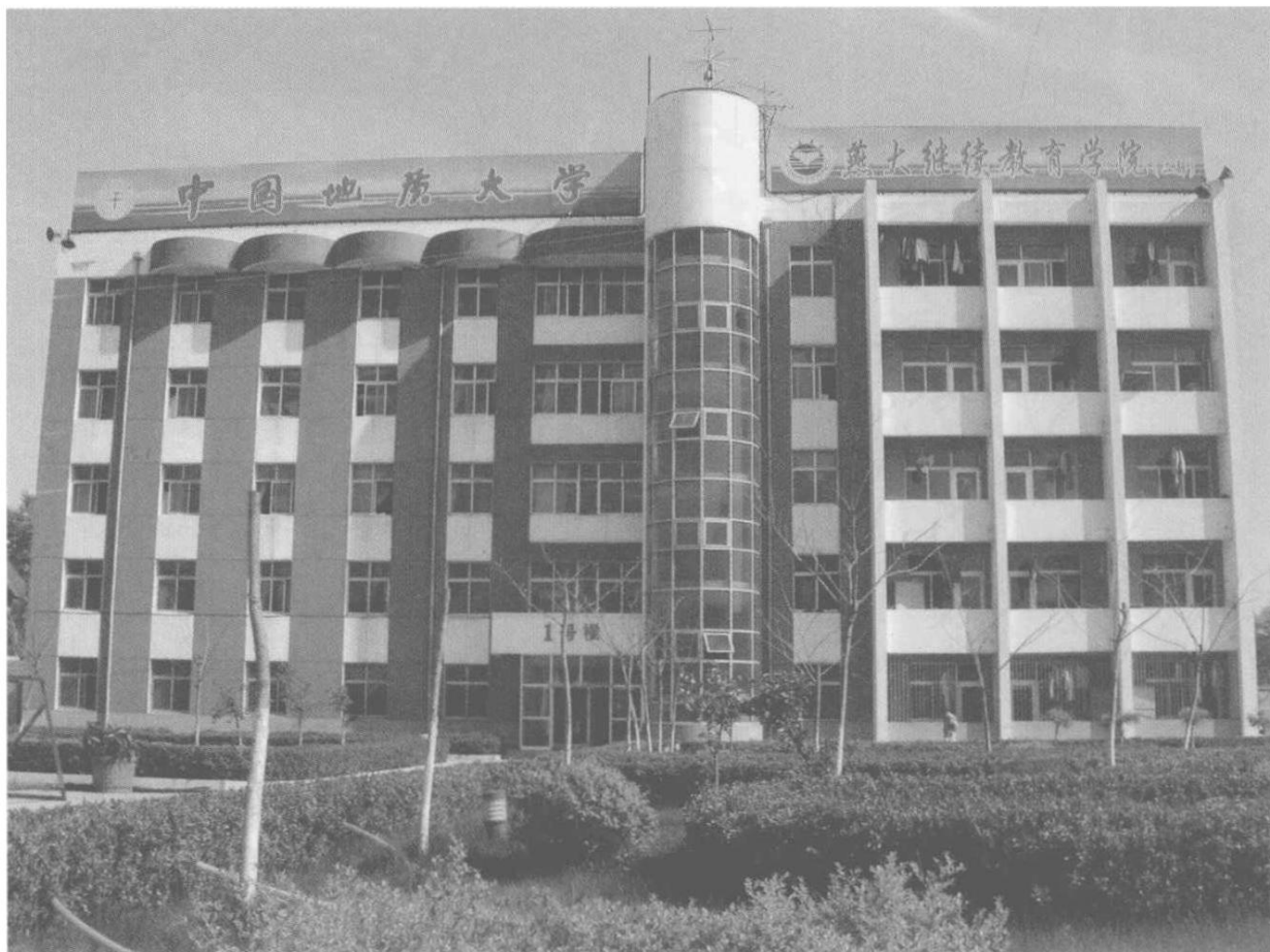
图 1-3 实习站综合楼(1995 年投入使用,王家生摄于 2004 年)
