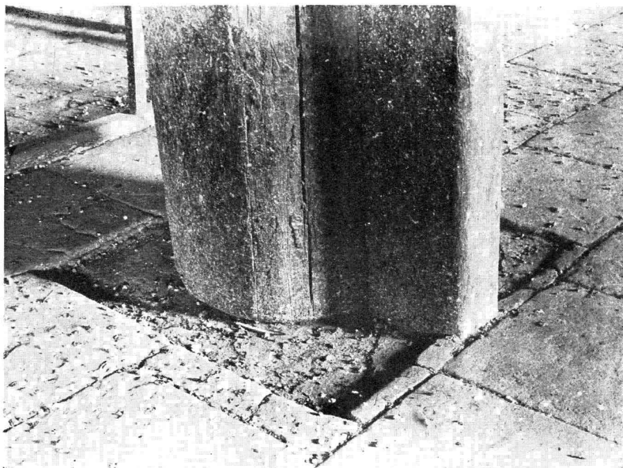
甲 大同善化寺大雄寶殿平柱礎
