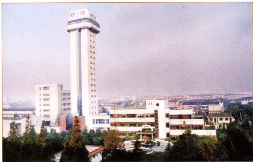
▲新纺集团电梯厂试验塔
