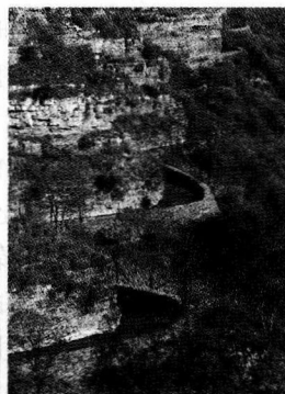
建成通水后的渠道
