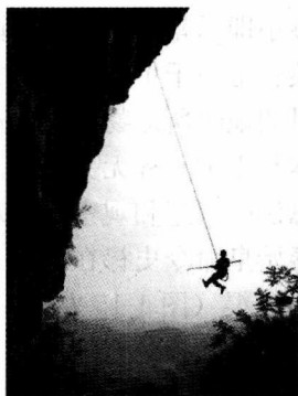
悬吊在悬崖上施工的民工
