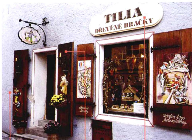
墙面拉毛喷涂石质漆
