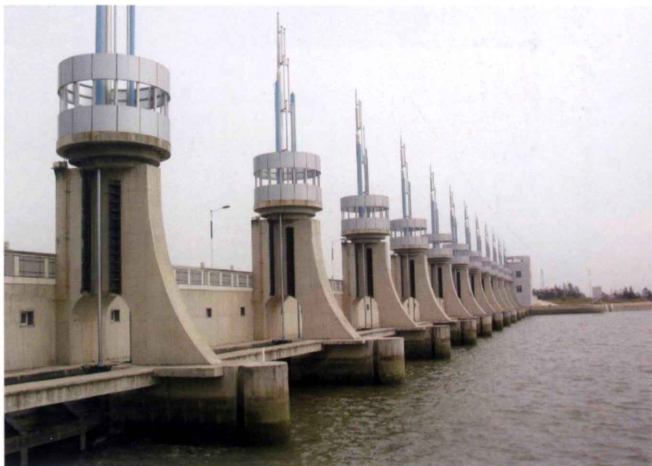
2006年底完成重建的中珠联围大涌口大型水闸。
