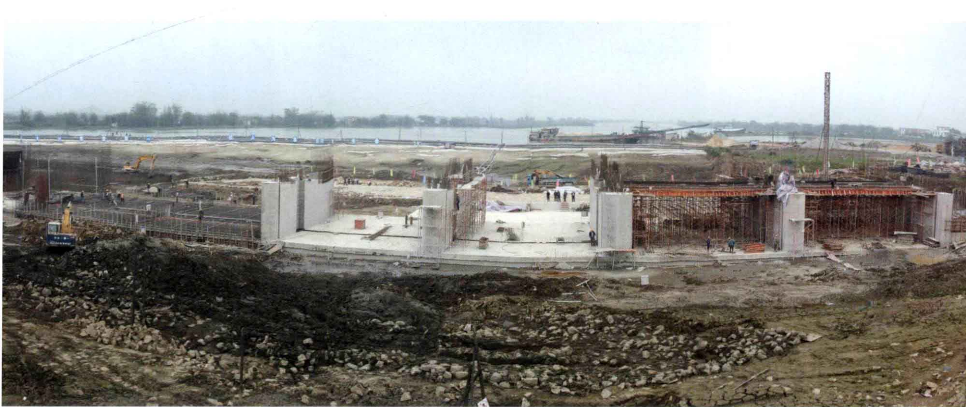
中珠联围大涌口水闸重建工程施工全貌。
