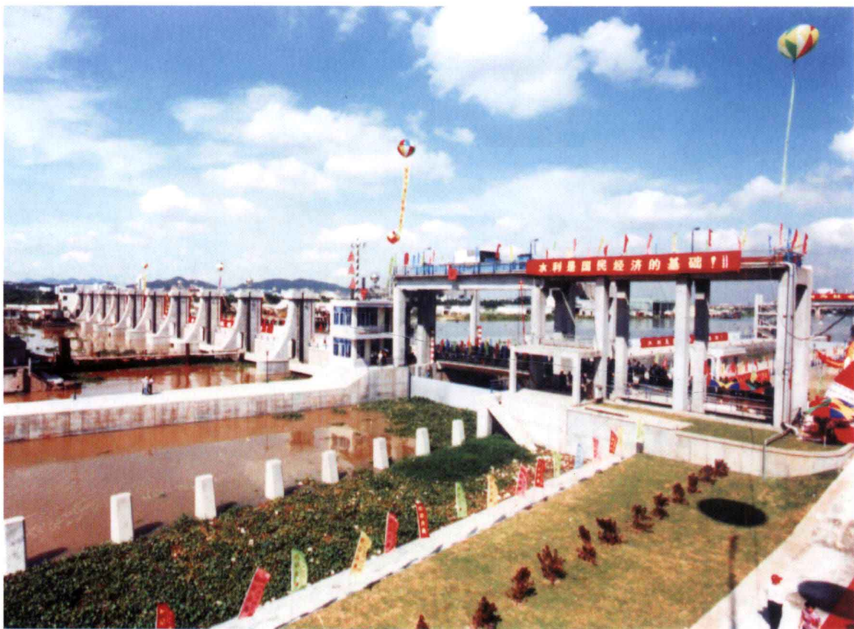
东河水利枢纽工程建成投入运行。
