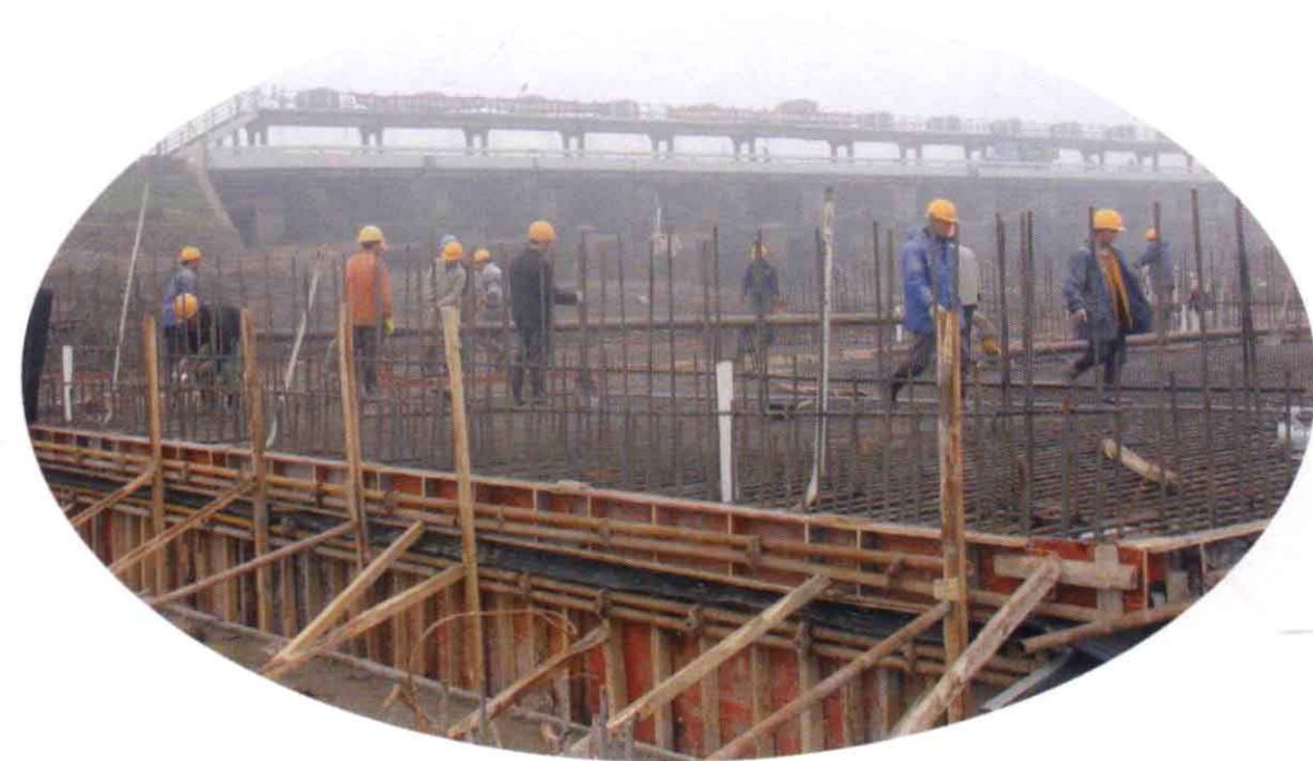
2005年2月，中珠联围大涌口水闸重建工程动工，施工人员抢浇第一块水闸闸室底板。
