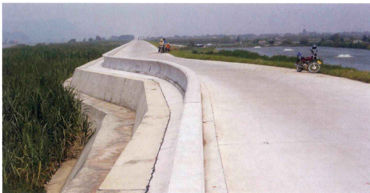
采取戗台加防浪墙，提高干堤防洪能力。
