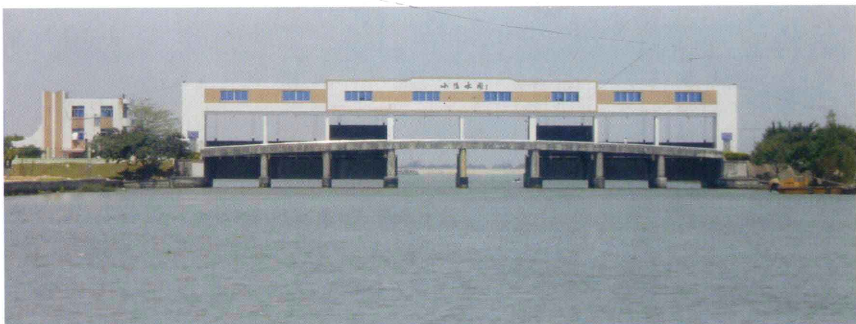
1996年重建的张家边联围小隐水闸。
