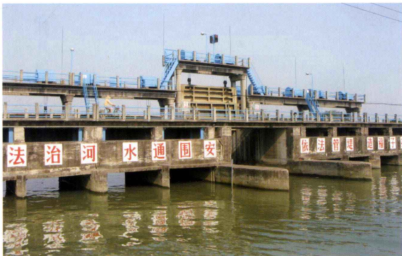
1992年加固的 中顺大围铺锦水闸。
