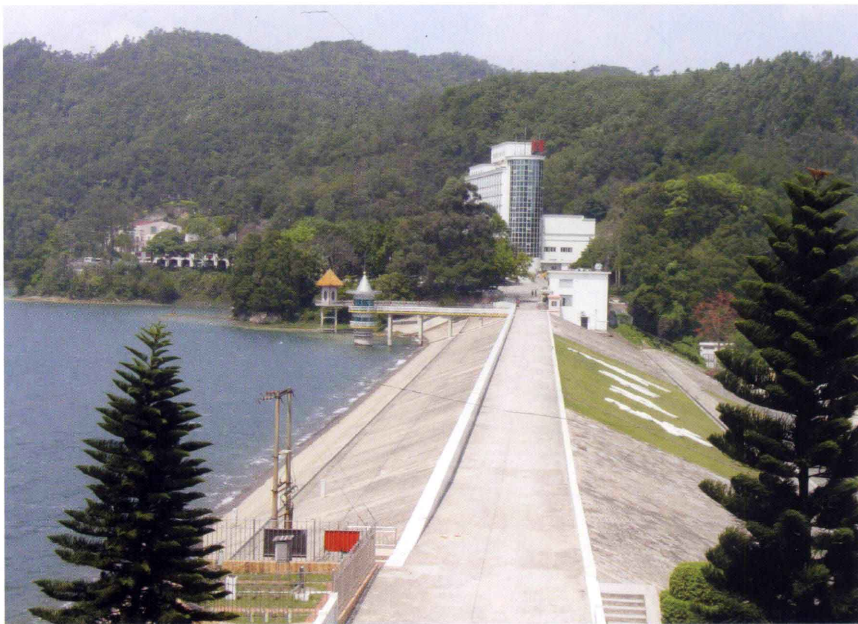
加固后的长江水库大坝新貌。
