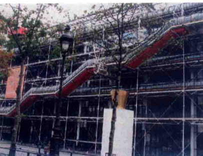
樓梯、水管外露，像工廠的龐畢度文化中心
