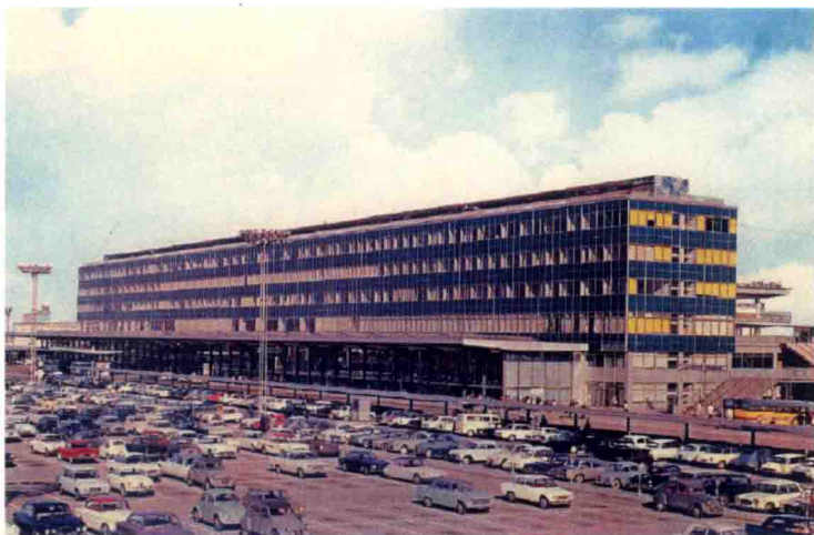
巍峨壯觀的渥利機場
