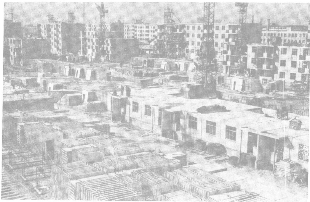
图 II-0-1 装配式建筑工地现场
