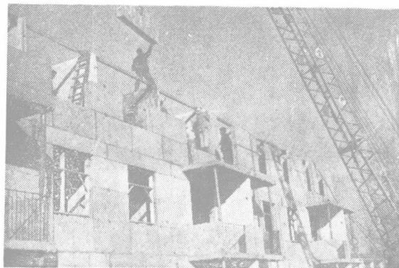
图 II-1-3 砌块建筑在施工
