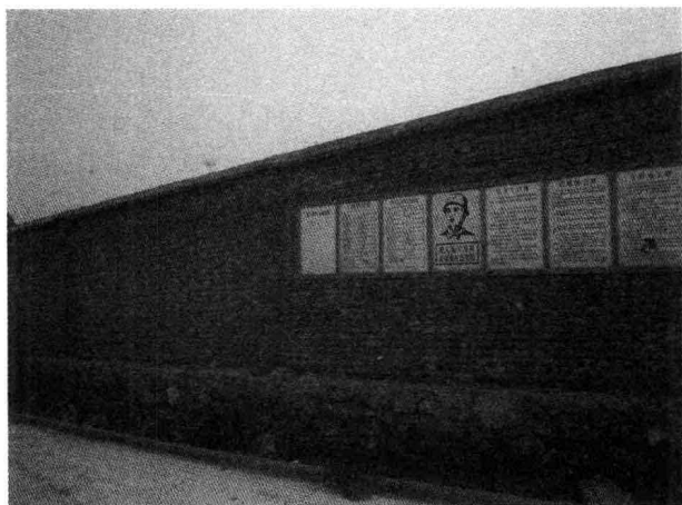
图 1.1 建筑工地围墙
