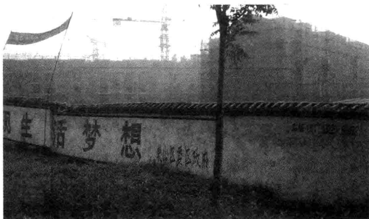
图 1.5 建筑围墙盖顶
