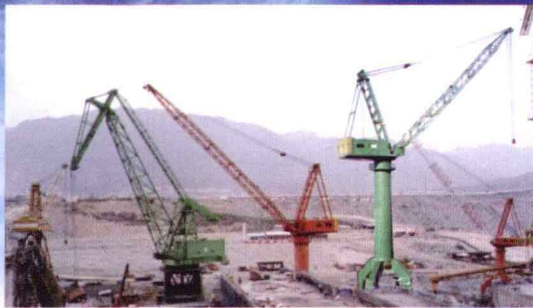
图为长江三峡工程制造的4台 QT600\text{t} \cdot \text{m} 门式起重机(图中绿色和桔黄色圆筒型门机)在三峡大坝右岸非溢流坝面上进行作业的情景
