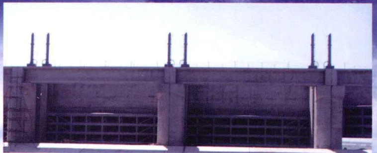
中国河口第一大闸——曹娥江大闸，闸门采用双拱空间网架式结构形式，闸门宽 \times 高为 20\text{m} \times 5\text{m} ，该闸门结构新颖，属国内首创
