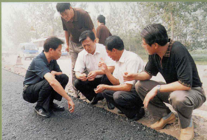
局长谢广居(中)到干线公路(徐丰段)的施工现场检查工作
