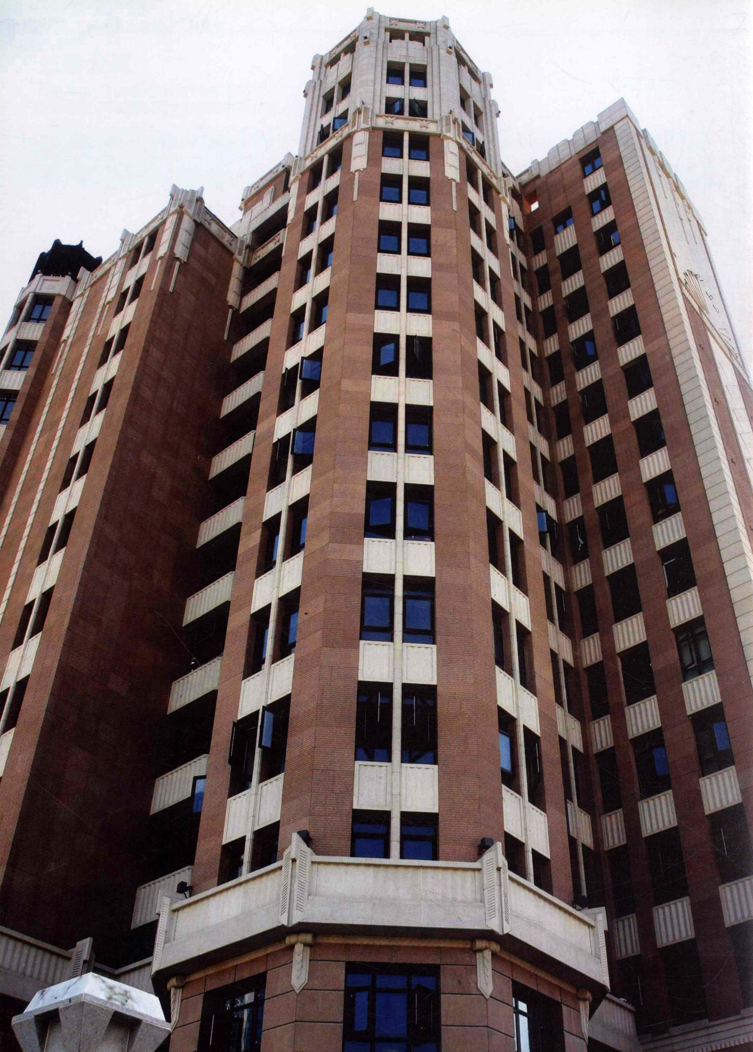
为停车和娱乐功能，需要大柱网空间，主楼剪力墙除电梯间和楼梯间外不能落地。为满足建筑功能要求，主楼部分在一层设转换层，通过转换大梁来转换上部住宅东
