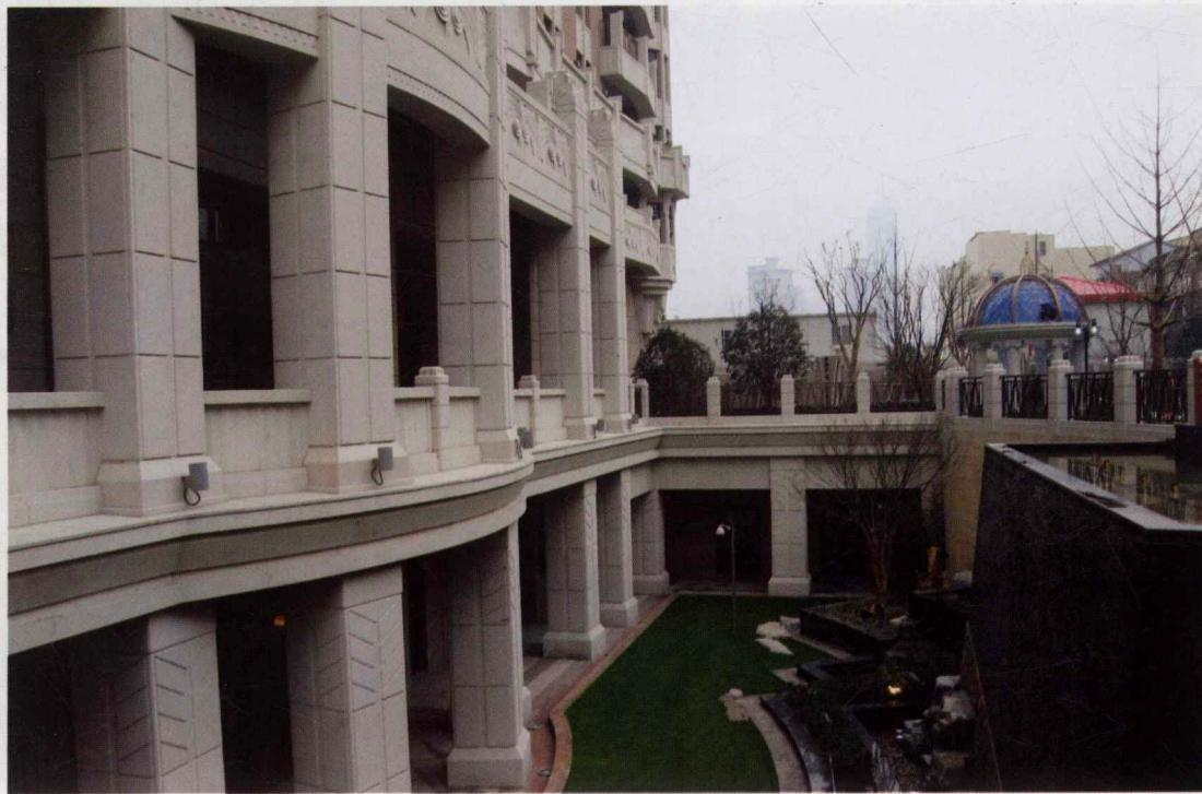
换层，通过转换大梁来转换上部住宅中间部分的剪力墙。转换层上部结构采用剪力墙结构。本建筑四角均为圆弧窗，结构的扭转效应明显，为增加结构的扭转刚度，外墙尽量满布剪力墙并加厚，调整剪力墙布置，使刚心与质心尽量接近。还将四角窗台梁上翻，增加梁的高度。
