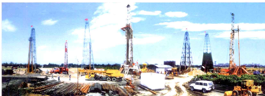
注浆堵水施工现场，郑州煤电集团地质勘探工程公司，中煤大地技术开发公司，中原石油勘探局钻井一公司，华北油田钻井分公司的钻机（从左至右）正在紧张施工。
