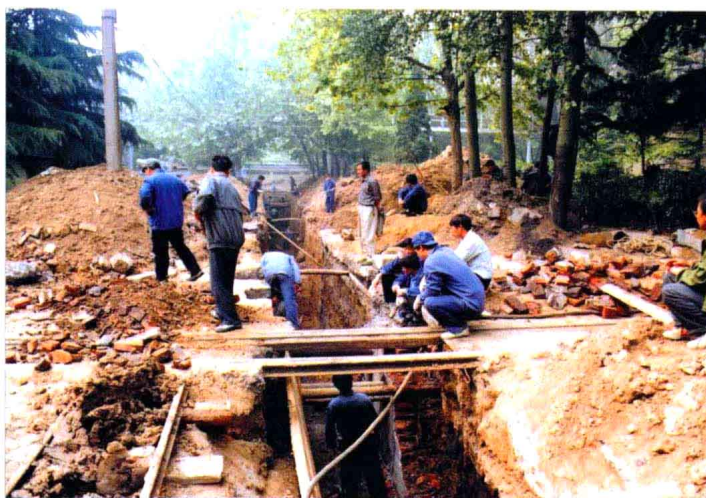
东庞矿职工加班加点抢 挖排水沟。（2003年5月13 日）
