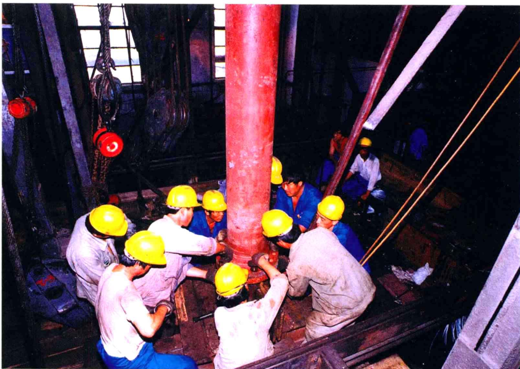
2003年8月6日,副井开始安装第一台排水大泵。
