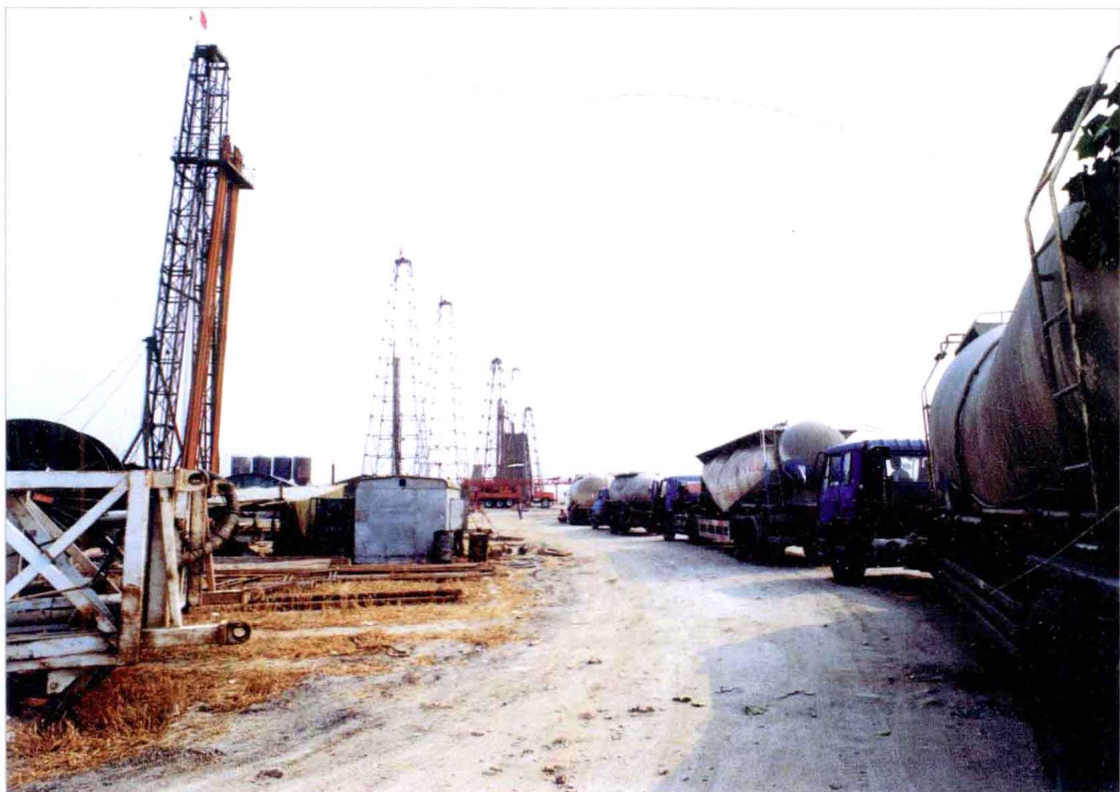
各种先进的钻机日夜轰鸣，注浆工地紧张有序。
