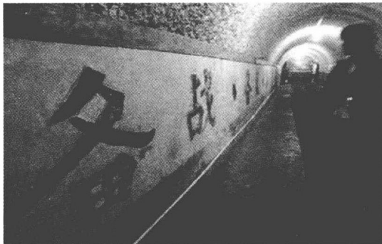
◎ 当时开挖的北京地下防空洞
