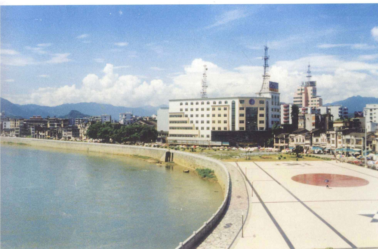
▲ 一河两岸防洪河堤
