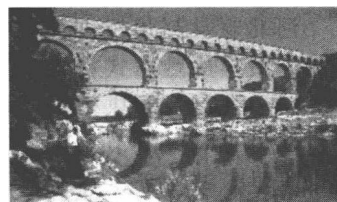
图 1-8 加尔输水道桥
