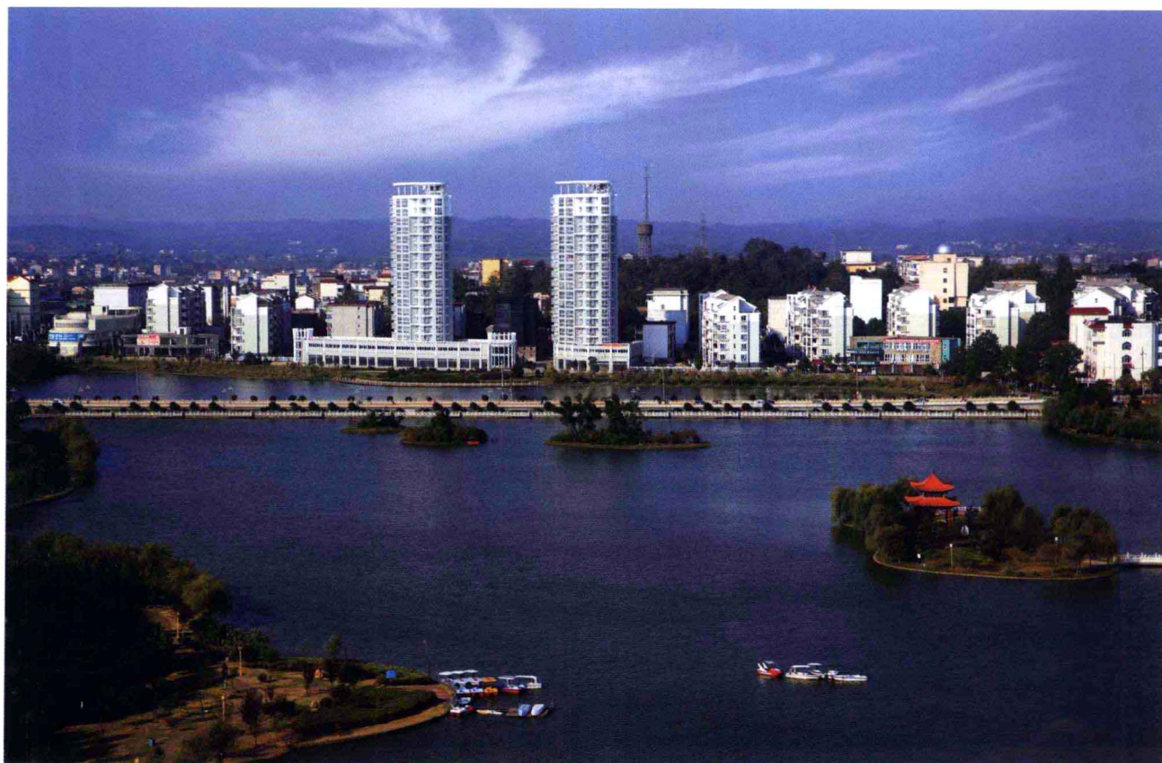
吉安县龙湖左岸小区
