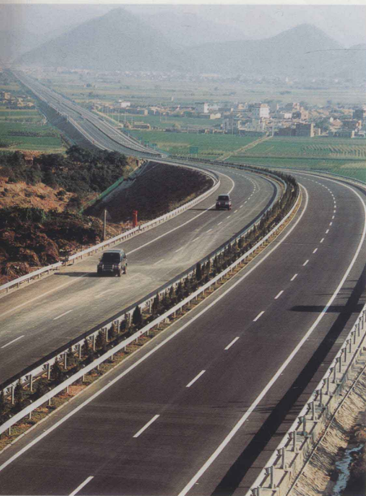
至 2002 年底,福建高速公路里程达 700 公里。图为省重点建设项目漳州~诏安高速公路 2002 年 12 月 28 日建成并试通车。
