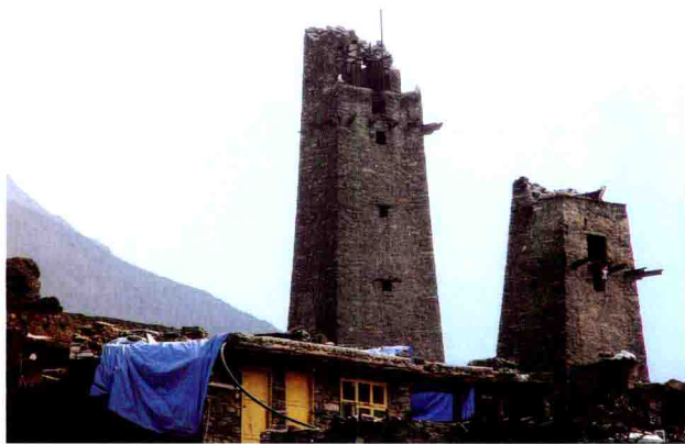
5·12大地震后雄伟的碉楼遭到破坏
