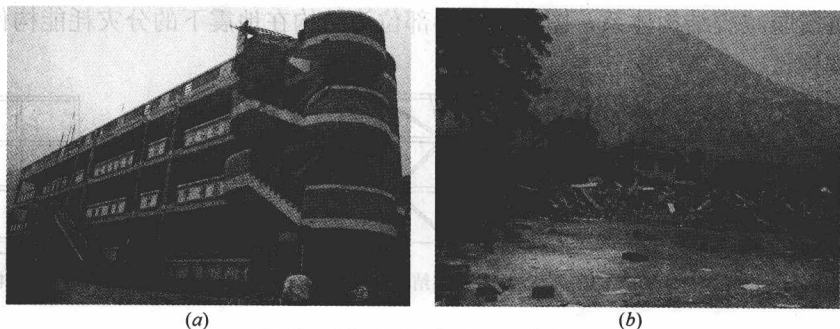
图 15-8 汶川地震中某小学两栋教学楼的震害对比
