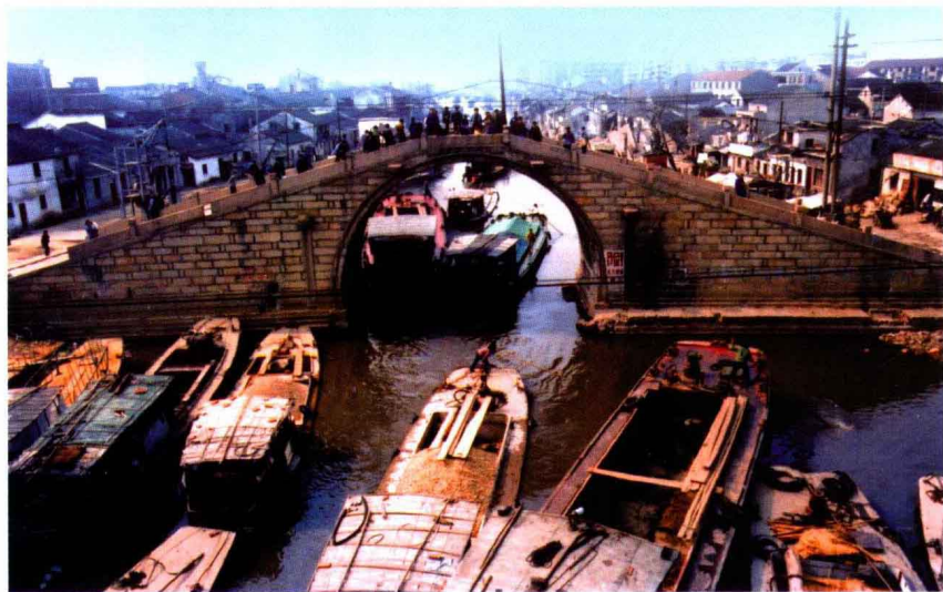
戚墅堰东的惠济桥两边的水位落差大,船只通行困难,事故多发
