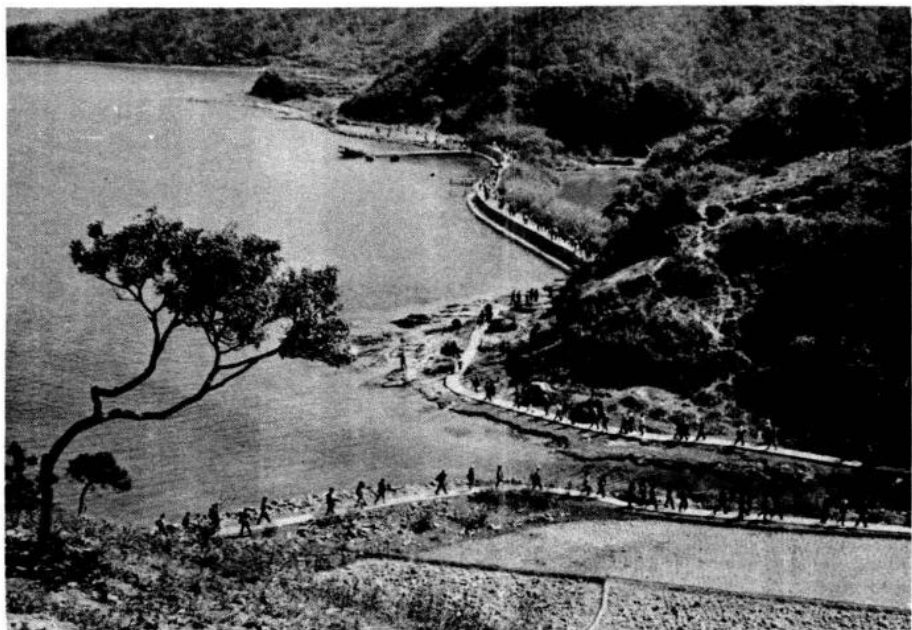
鹿頸到風坑途中鄉道
