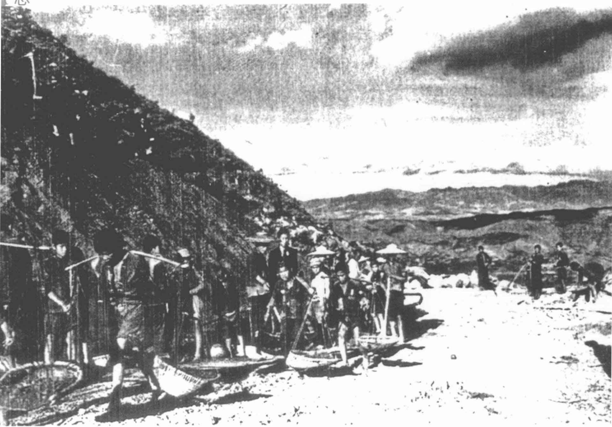
▲ 修筑滇缅公路全赖肩挑手挖
