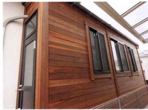
① 为狗狗和小猫打造的宠物之家。外壁用金刚木围得很密实。屋顶使用了金属材质，地面铺砌了瓷砖，设置了很多扇窗户。此外，屋内还装有空调哦！
