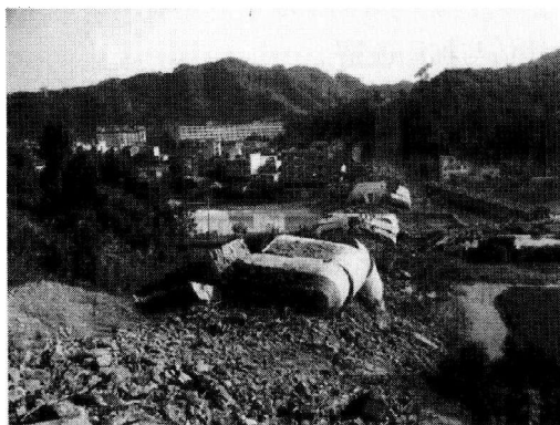
图1-10 湖南凤凰沱江大桥 (2007年8月13日坍塌)
