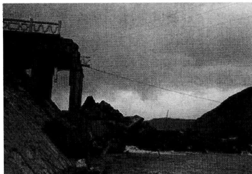
图1-7 甘肃省岷县洮河大桥 (2006年5月16日坍塌)
