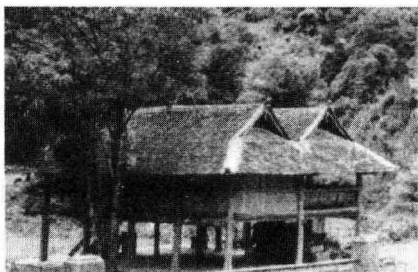
图 0-1 传统的吊脚楼
