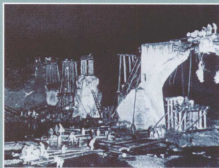
志愿军铁道兵部队在抢修被毁桥梁
