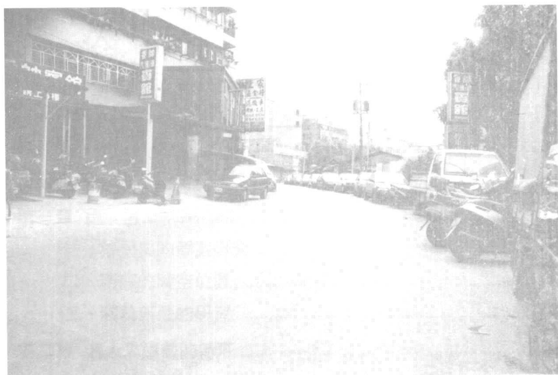
舊日新莊水圳加蓋後的道路現狀
