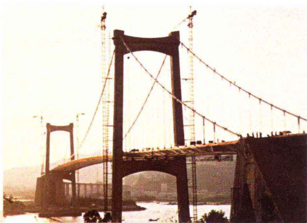
▲ 厦门海沧大桥
