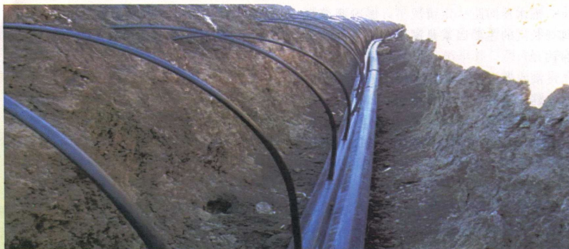
图 1-6 地埋支管示意图
