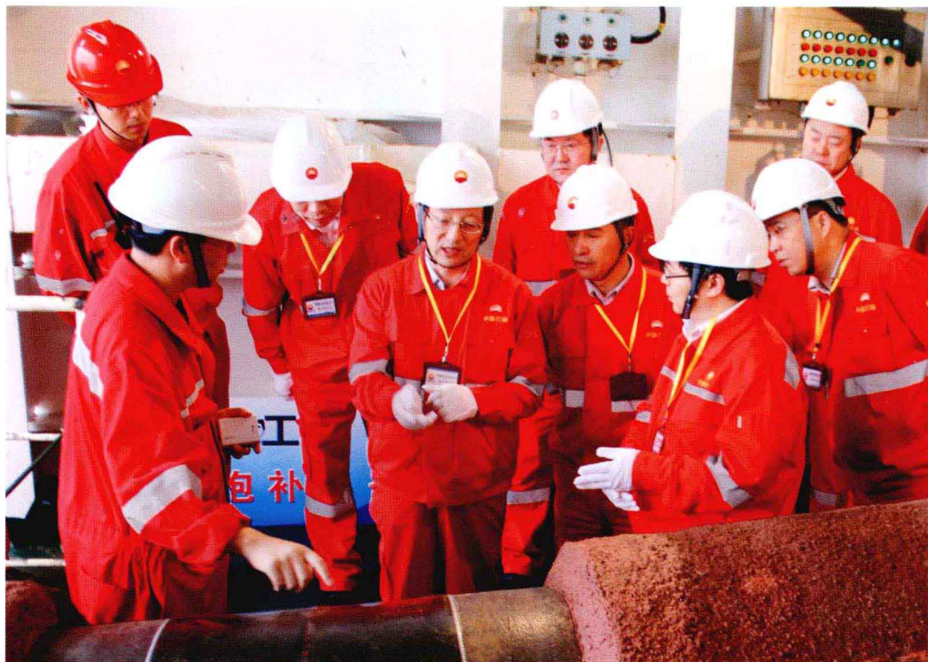
2012年2月25日，中国石油集团海洋工程有限公司总经理黄立功（中）到深港海管工程施工现场检查指导工作
