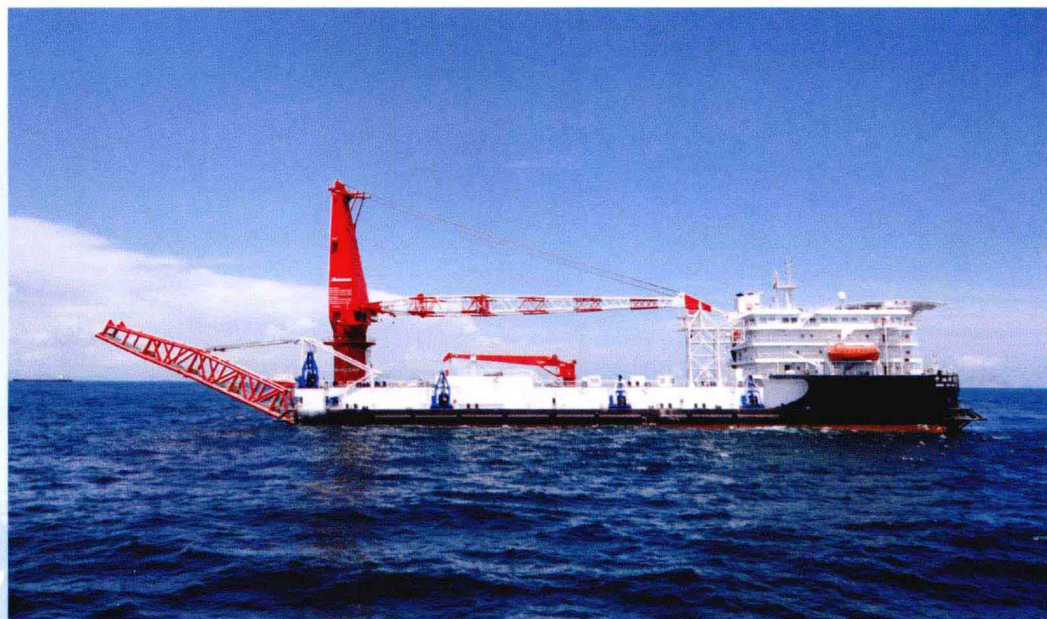
中国石油集团海洋工程有限公司所属的中油海 101 铺管船承担了深港海管香港支线 19.6 千米的铺设任务
