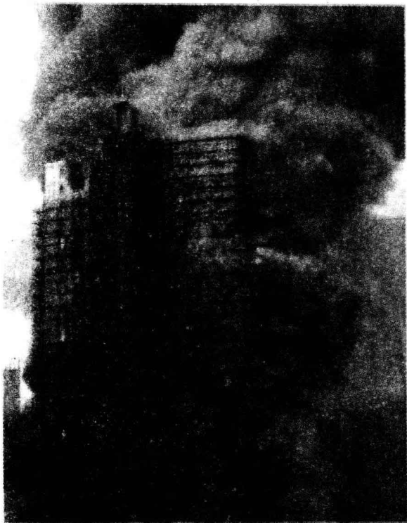
▲ 无情的大火烧毁了整栋大楼
