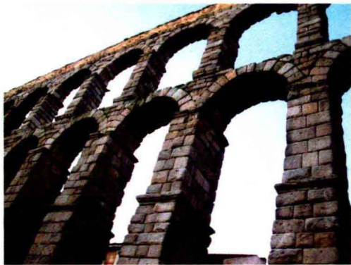
图1-3 古罗马的3层叠起连续拱券输水道
