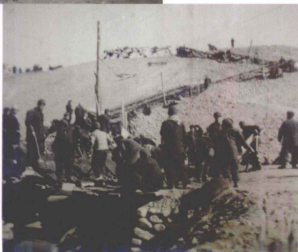
往大坝上运料的爬坡机
