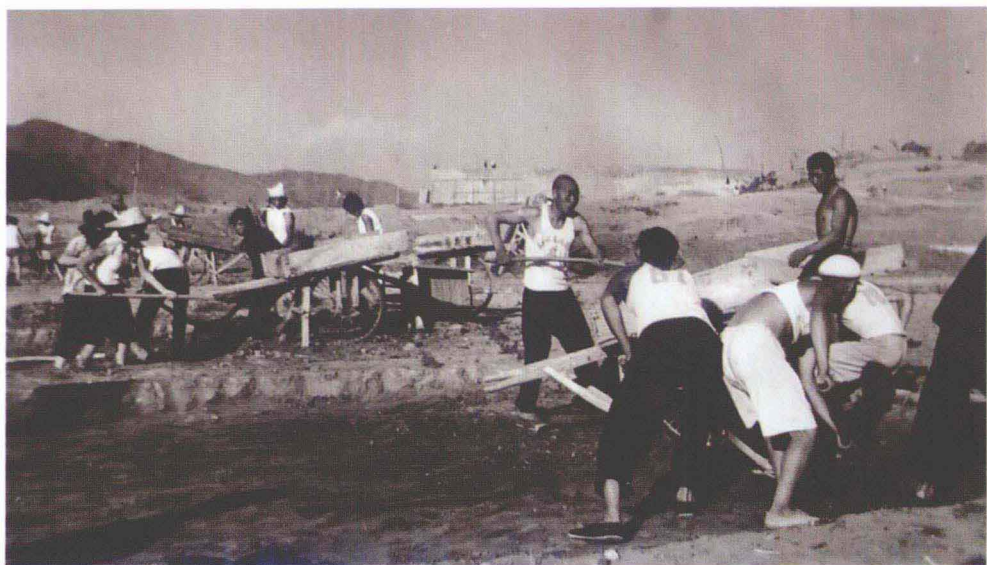
▲水库工地劳动情景之一
