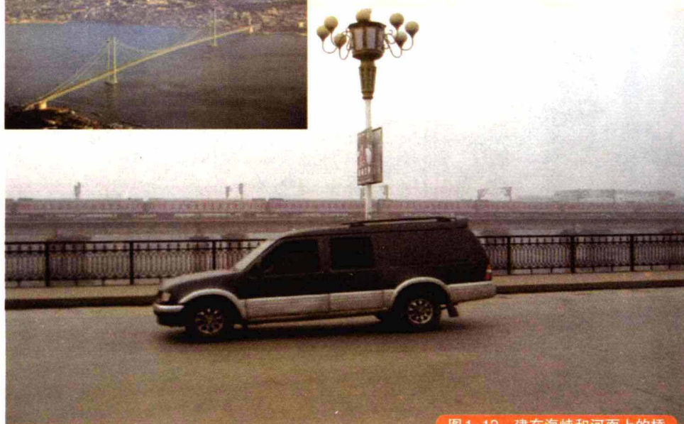
图 1-12 建在海峡和河面上的桥
