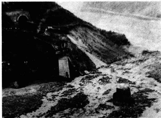
图 0.1 成昆线利子依达沟泥石流
