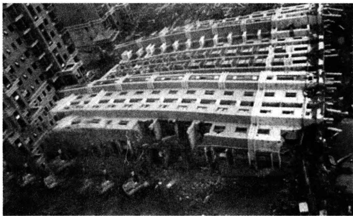
图 0.8 上海莲花河畔景苑整栋倒塌
