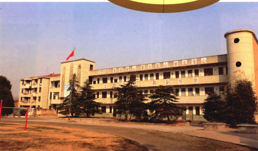
巡检村初中教学楼
