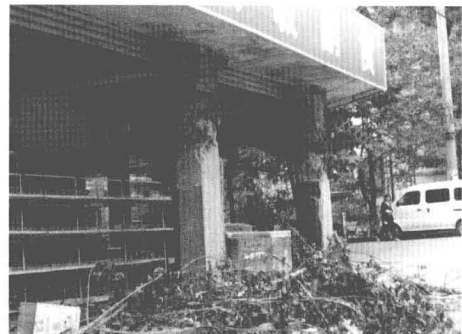
图 1.6 震损的钢筋混凝土结构房屋
