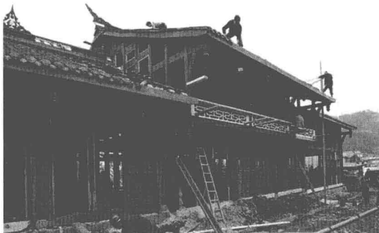
图 2.2 都江堰正在施工的穿斗结构房屋
