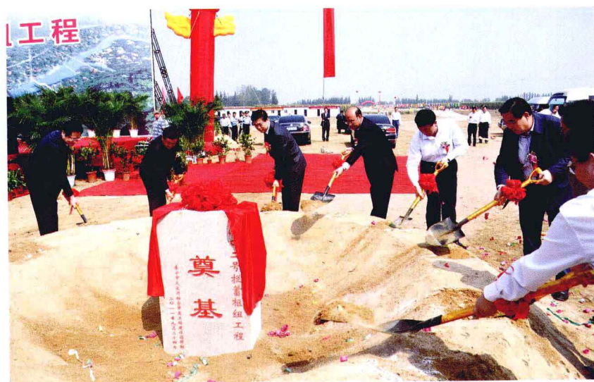
2011年9月24日，大汶河综合开发汶口二号拦蓄枢纽工程奠基开工。该工程位于大汶河干流上游河段，主要建设拦蓄工程、堤防护坡工程、平原水库、渠道工程及景观工程等 (李鹏 摄)
